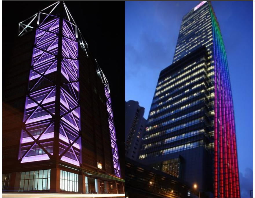
圖 10：星亞與建築照明事務所合作，提供建築物帷幕照明燈條
